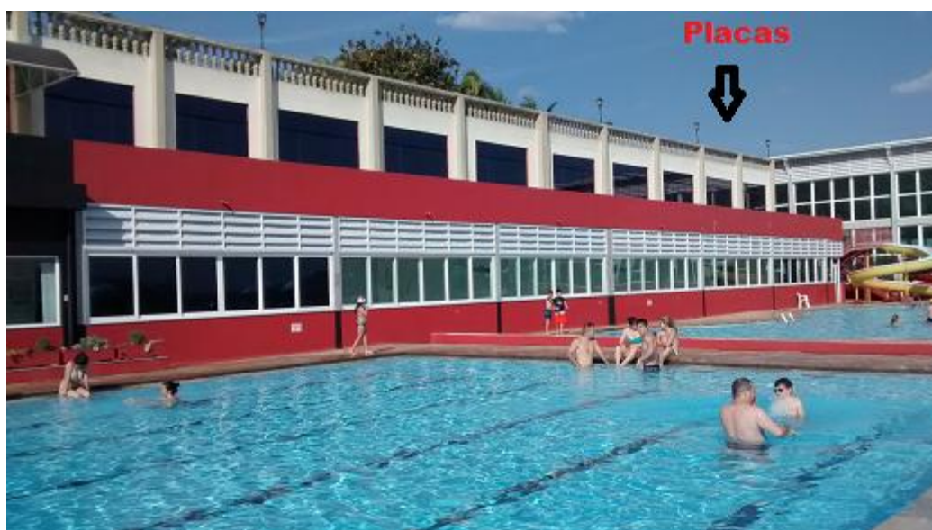
Figura 3.4 – Fotografia do local onde serão colocadas as placas
